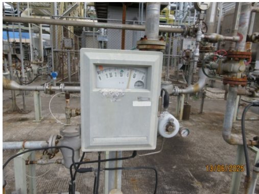
รูปที่ 3.2-13 ระบบ Flow Meter
