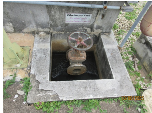
รูปที่ 3.2-42 Block Valve
