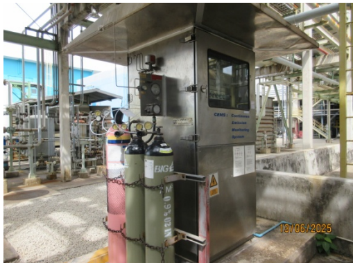
รูปที่ 3.2-3 Continuous Emission Monitoring System, CEMS
