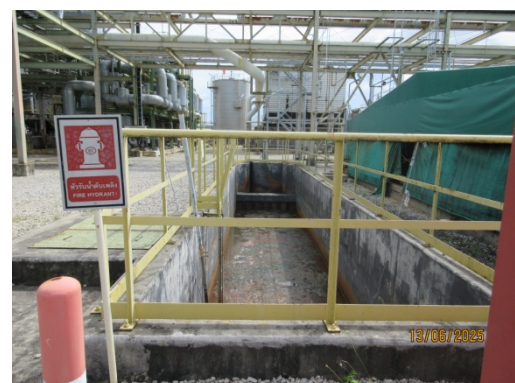
รูปที่ 3.2-10 Oil Separator
