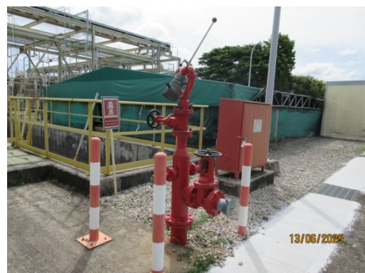
รูปที่ 3.2-34 Fire Hydrant
