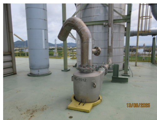
รูปที่ 3.2-4 Cyclone ชุดที่ 1 MC-1512
