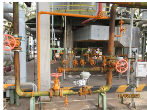
รูปที่ 3.2-46 วาล์วตัดแยกระบบท่อขนส่ง ก๊าซธรรมชาติ
