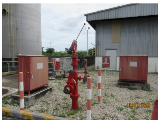
รูปที่ 3.2-50 Fire Hydrant บริเวณท่อขนส่งก๊าซธรรมชาติ
