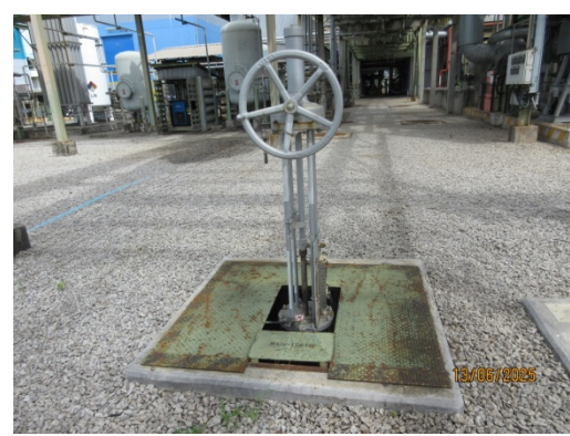
รูปที่ 3.2-16 วาล์วตัดแยกระบบบำบัดน้ำเสีย
