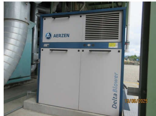
รูปที่ 3.2-20 ที่ครอบเครื่องจักรป้องกันเสียง
