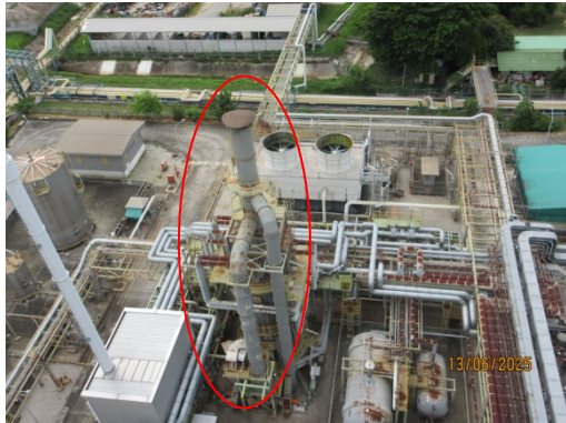
รูปที่ 3.2-1 ปล่องระบายอากาศ HTM Heater ชุดที่ 1 (F-1901)
