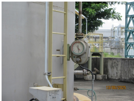
รูปที่ 3.2-43 อุปกรณ์วัดระดับสารเคมี (Level Indicator, Level Gauge)
