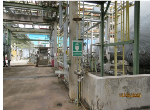
รูปที่ 3.2-30 ฝักบัวและอ่างล้างตาฉุกเฉิน
